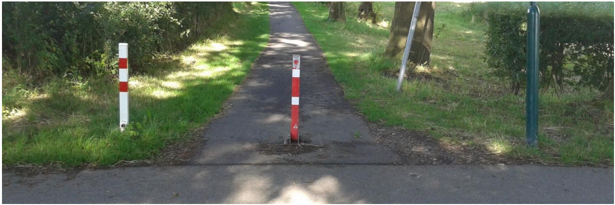
Figuur 4: Slecht voorbeeld van smal fietspad. Paal op fietspad i.p.v. palen aan beide zijden in de berm. Ook te dicht op het kruispunt.
