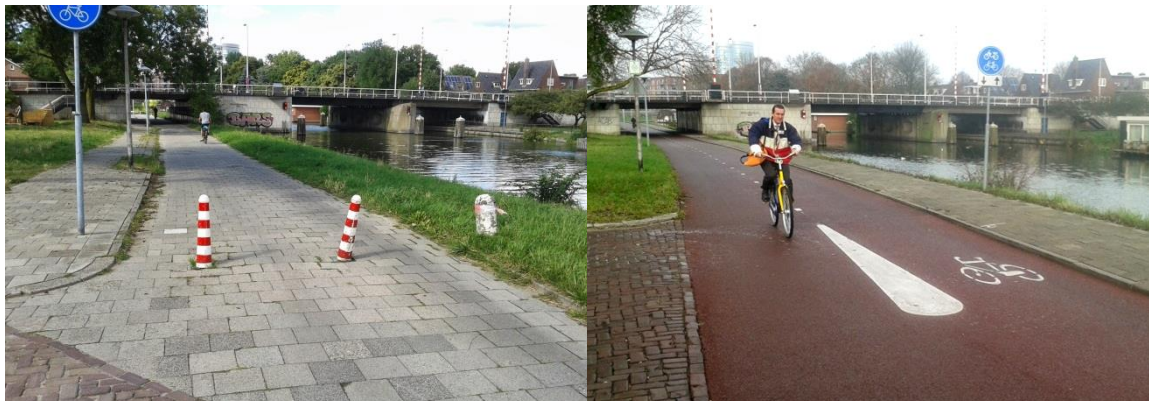
Figuur 1. Voorbeeld van een fietspad met hinderlijke paaltjes (links) en hetzelfde fietspad na reconstructie, waarbij de paaltjes zijn vervangen door markering.
