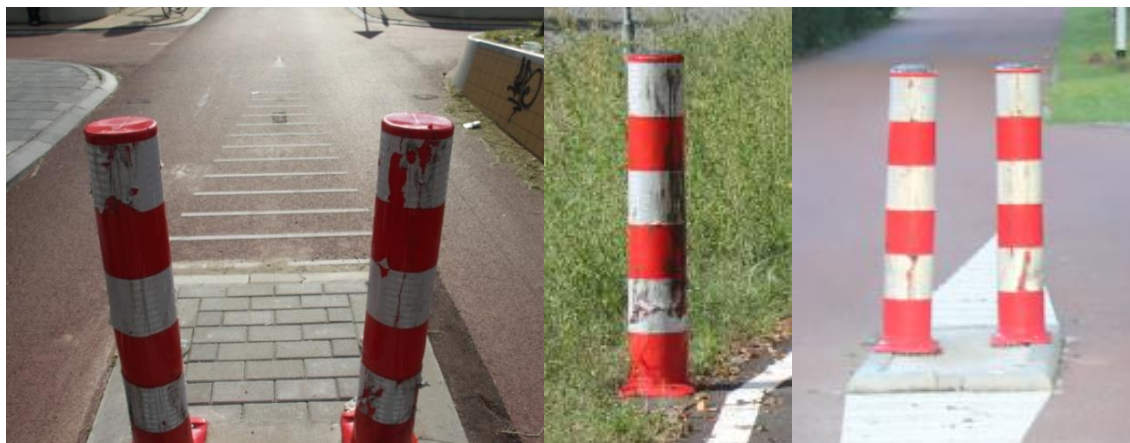
Figuur 12: Beschadigen op overrijdbare palen in Barneveld (links), Hardenberg (midden) en Houten (rechts).
