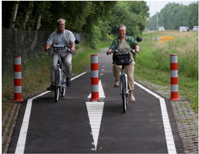
Figuur 5: Links slecht voorbeeld van paal op smal fietspad. Doorgang is te smal, vlak voor kruispunt en markering ontbreekt. Rechts proeflocatie in Hardenberg. Fietspad is ter hoogte van palen verbreed tot 330 cm. Fietzers benutten extra ruimte om meer afstand te houden tot palen.
