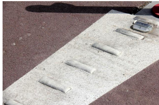
Figuur 9: Voorbeeld van betonhobbels die fietsers een laatste waarschuwing geven dat ze afkoersen op een paal. Leverancier Via van Dalen. Hoogte 8 mm. Onderlinge afstand ongeveer 15 cm.
